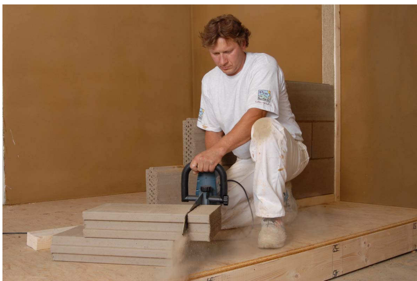
Řezání hliněných stavebních prvků pomocí elektrické pily Bosch Gfz 16-35 AC
