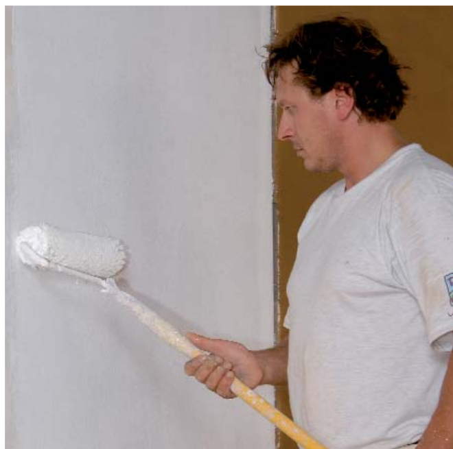
Nanášení hliněné barvy můžete provádět štětkou nebo válečkem.
