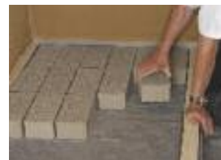
Položení cihel s 5 mm mezerami
