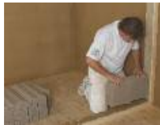
Osazení hliněnými prvky
