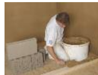
Příprava ložné spáry
